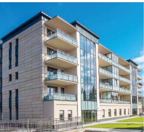
Budynek przy al. Piłsudskiego 52
